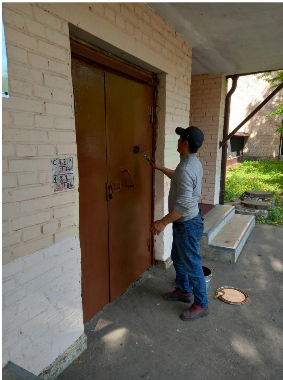
Софийская 30-2 покраска входных дверей.
